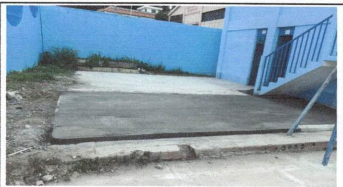
Foto 4: Reparacion de piso de torta de concreto
